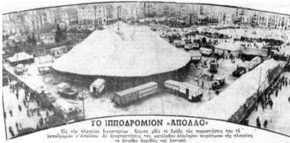
Εικ. 8. Τσίρκο στον άδειο χώρο της περιοχής.
