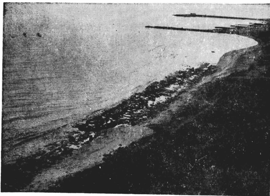
2. Ὁ «κλιμενοβραχίων» μόλις διακρινόμενος στὴν θάλασσα καὶ ὁ σωρὸς τῶν ἀρχιτεκτονικῶν μελῶν στὴν ἀκτὴ. Φωτογραφία ἀπὸ τὸν Παλαιόπτεργο (1977)
