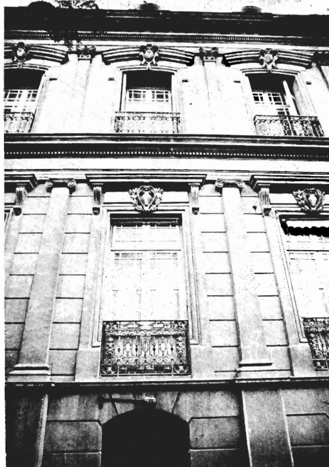
Photo 15. Détail de la façade latérale.
