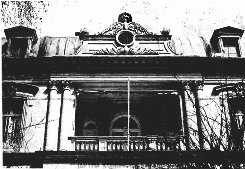
Photo 14. Détail de la façade principale.
