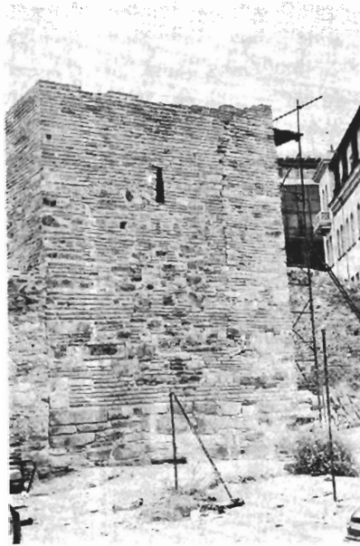
Εἰκ. 16. Ἡ νότια πλευρὰ τοῦ πύργου Ἀναγλύφου, μετὰ τὶς στερεωτικὲς ἐργασίες
