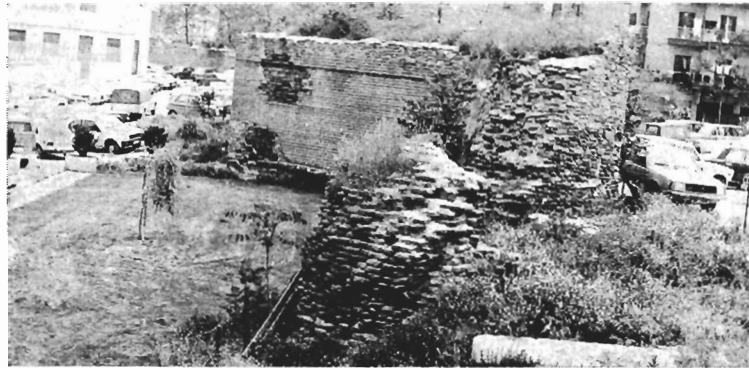
Είκ. 1. Τμήμα τοῦ δυτικοῦ τείχους τῆς Θεσσαλονίκης, ἐνσωματωμένο στοῦ Φρούριου Βαρδαρίου. Διακρίνεται ἡ τοιχοδομία του με ἀποκλειστική χρήση πλίνθων
