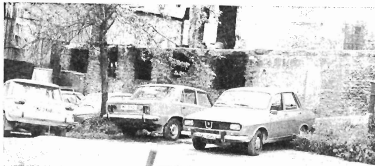
Εικ. 21. Τò μηχανογείο όπου διατηροόνται λείψανα τοϋ πύργου τοϋ Τζερέμπουλου
