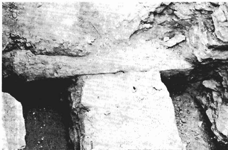
Εἰκ. 20. Ὁ τοῖχος μὲ τοὺς μεγάλους μαρμαρίνους δόμους, κάτω ἀπὸ τὴ διτικὴ πλευρὰ τοῦ πύργου Ἀναγλύφου
