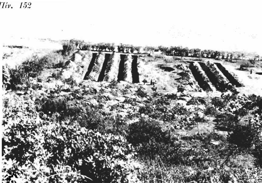
α. Ἀπὸ Ν ἀποψη τῶν скаμμάτων γιὰ τὴν ἀνάγεσση τοῦ ξενοδοχείου στὴ θέση τοῦ Ἀμμωνίου καὶ τῶν σωρῶν τῶν ἀπορριμάτων ἀπὸ τὶς ἐκσκαφές (φωτ. 28.9.68) (126)
