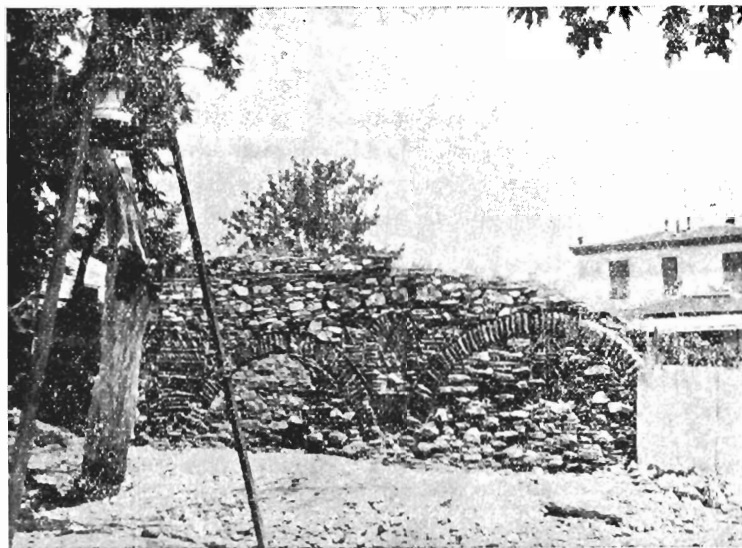
Εἰκ. 4. Ὅψις τμήματος τῆς νοτίου πλευρᾶς τῆς κινστέρας
