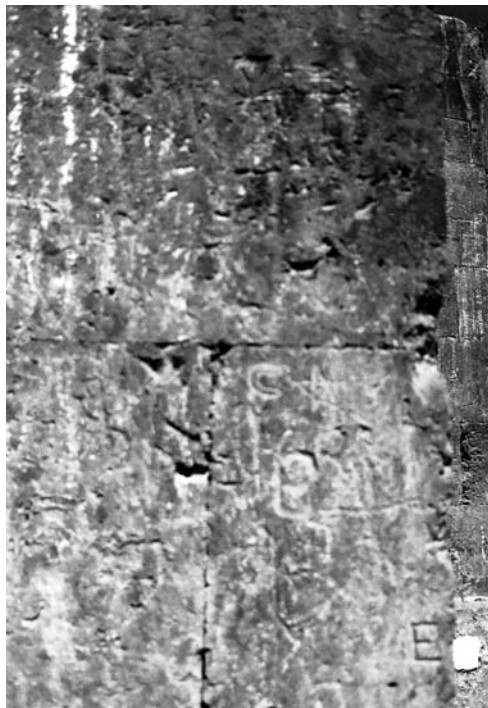
Εικ. 10. Οι δόμοι γωνιόλιθοι της ΝΑ γωνίας. Μεσημβρινή όψη. Διακρίνονται διάφορα ακιδογραφήματα.
