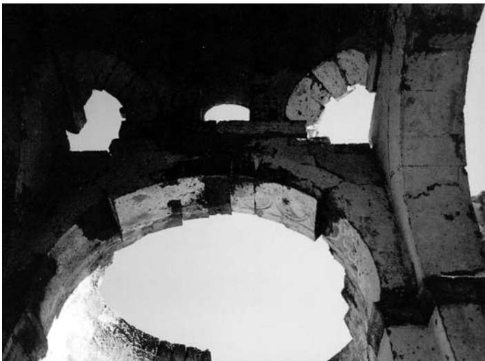
Εικ. 6. «Κόκκινη Εκκλησία». Εσωτερική άποψη του τρόπου εδράσεως του τρούλου. Fig. 6. «Église Rouge». Vue intérieure du moyen de support de la coupole.
