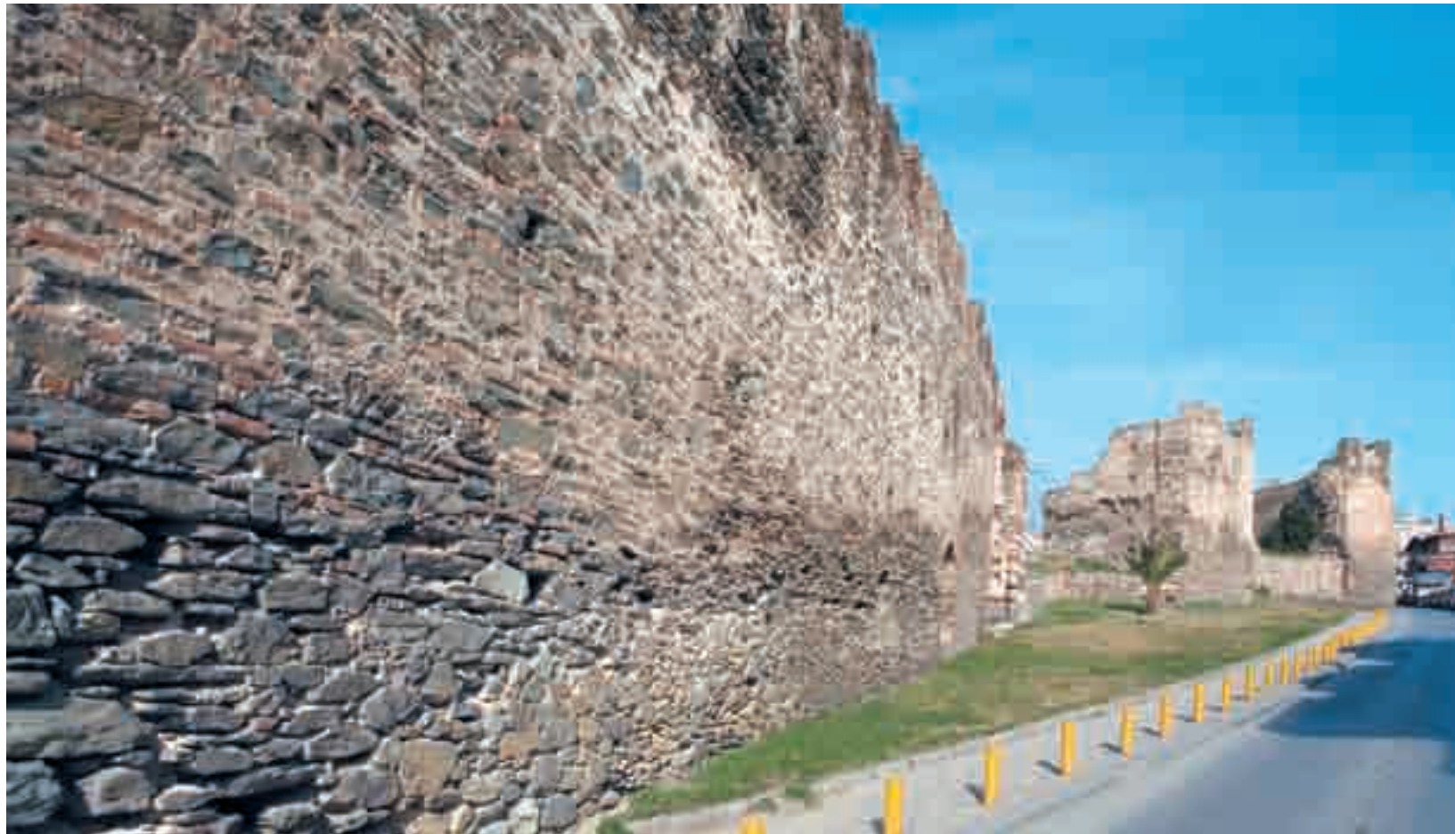
Σύγχρονη λήψη της ίδιας περιοχής (φωτ. Ν. Στυλιανίδη, 2008).
