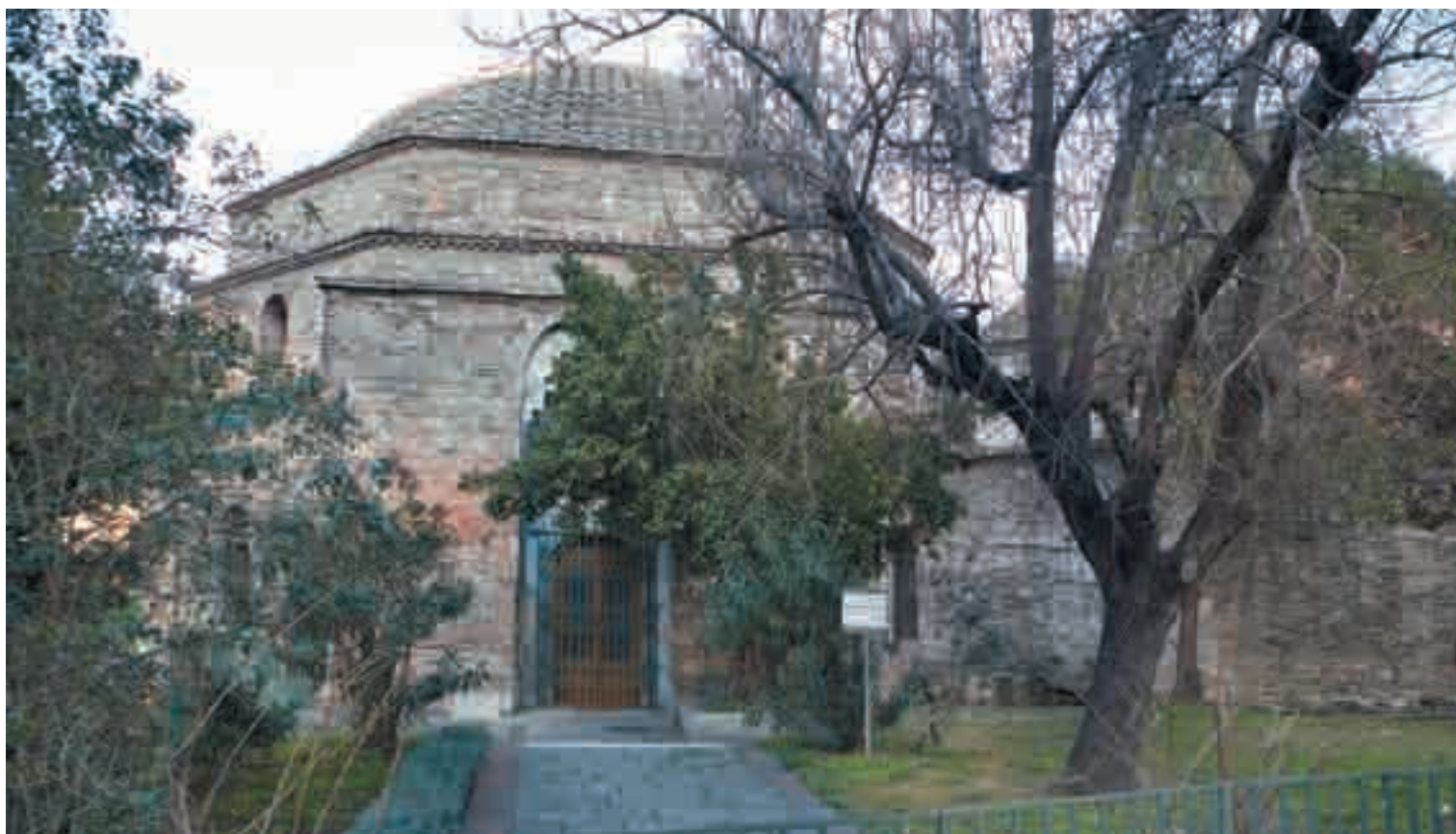
Το λουτρό «Παράδεισος» στην Εγνατία οδό, μετά τις εργασίες συντήρησης και αποκατάστασης που διενεργήθηκαν πρόσφατα (φωτ. Ν. Στυλιανίδη, 2008).
