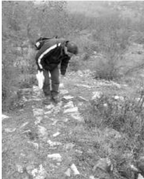
Εικ. 15. Διχαλεύρι. Μεταβυζαντινός οικισμός, τείχος κτηρίου.
