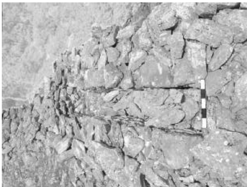
Εικ. 6. Μεγάλο Κασατρί. Ορθογώνια πυργοειδής κατασκευή στον βορειοανατολικό τμήμα του τείχους στο βόρειο λόφο.
