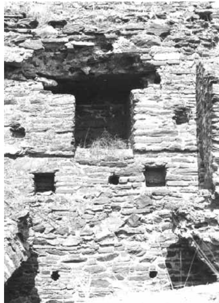
Εικ. 10. Τοιχοποιία κομβικού πύργου Π13. Υποδοχές του μηχανισμού τον «καταρράκτη» της πύλης. Ph. 10. Maçonnerie de la tour no 13. Récepteurs du mécanisme de la clôture de la porte (saracinesca).
