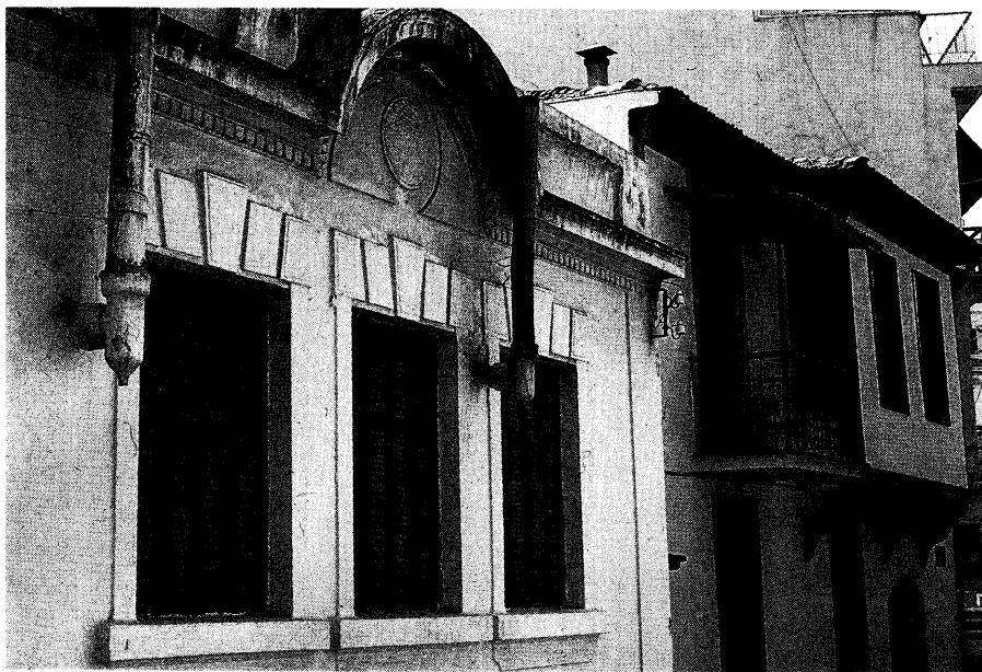
Ειχ. 23. Άνω Πόλη Θεσσαλονίκης: χαμτύλο αέτωμα στην οδό Ηροδότου (φωτ. του συγγραφέα, 1996).
