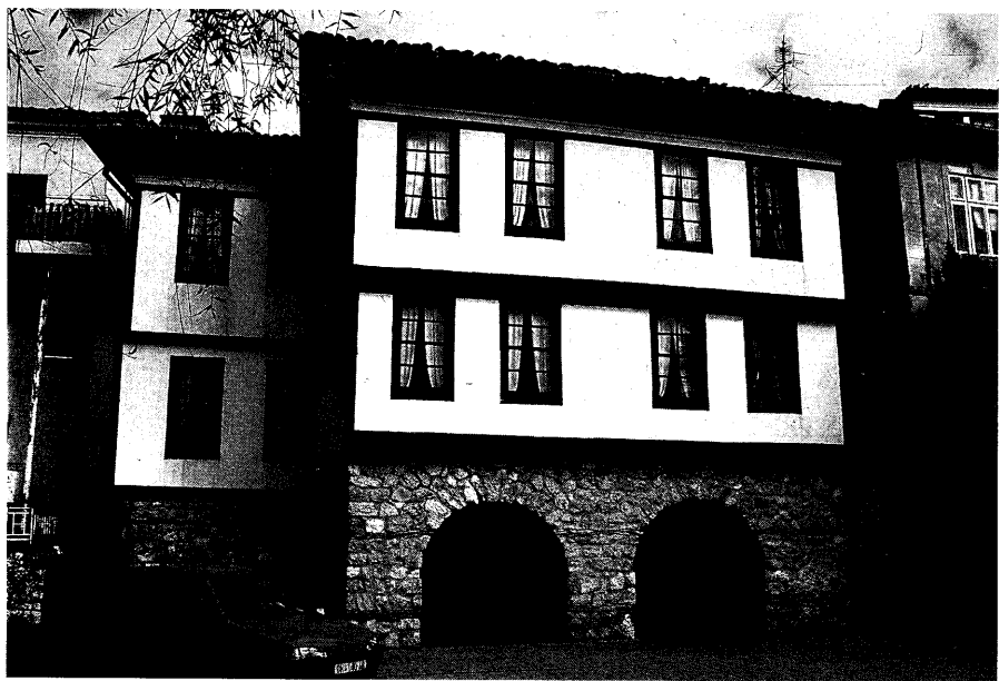
Ειχ. 24. Αχρίδα: πέτρινοι πεσσοί που συνδέονται με τόξα (φωτ. του συγγραφέα).
