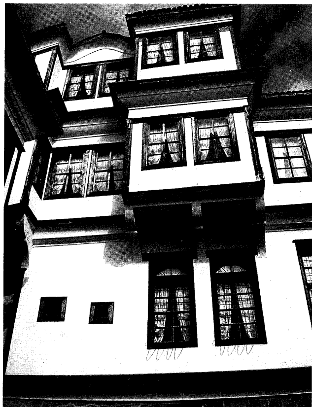
Εικ. 20. Αζοίδα, αρχοντικό Ρόμπη: καμπύλο αέτωμα και επάλληλα σαχνισιά (φωτ. του συγγραφέα, 1999).
