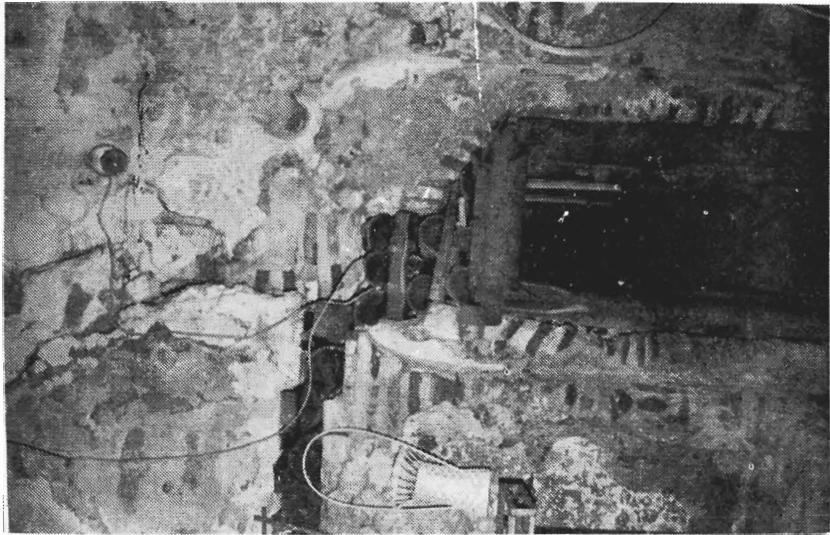
β. Ρογήμη μεγάλων είρων στο μετεβρεπτικό χώρο του ανδρικού τμήματος
