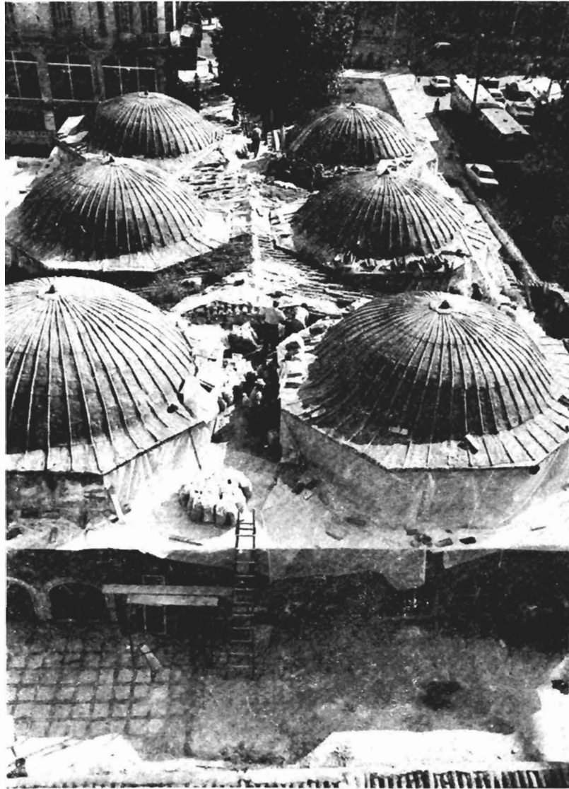
Εικ. 1. Γενική άποψη από Ν (φωτ. 1983).
