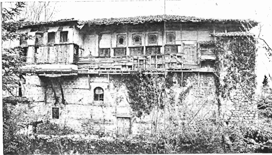
Εἰκ. 1. Βόρεια ὄψη τοῦ ἀρχοντικοῦ πρὶν ἀπὸ τὶς ἐργασίες
