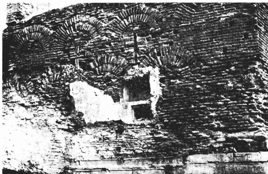
Εἰκ. 2. Τμήμα τοῦ δυτικοῦ τεύχους μετὰ διπλῶν τόξων εἰς δύο ἐπαλλήλους σειρὰς
