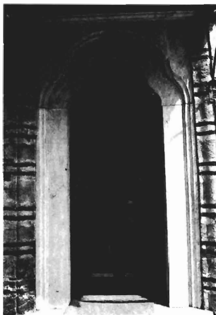
Εικ. 5. Θύρωμα νότιας εξωτ. πλευράς
