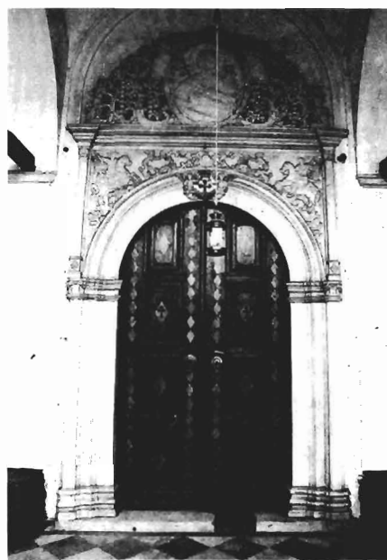
Εικ. 6. Κεντρικό θύρωμα εξωνάρθηκα
