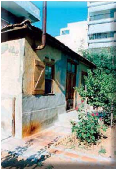
Εξωτερική άποψη προσφυγικής κατοικίας.
