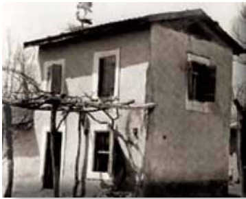
Διώροφη κατοικία (της Ε.Α.Π.) στο Πλατύ Ημαθίας. Πηγή: Γ. Γιαννακόπουλος, Προσφυγική Ελλάδα .
