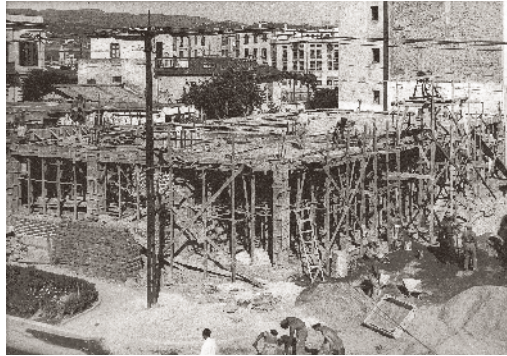
Η ανοικοδόμηση του πρώτου κτιρίου προχωρεί γοργά.
